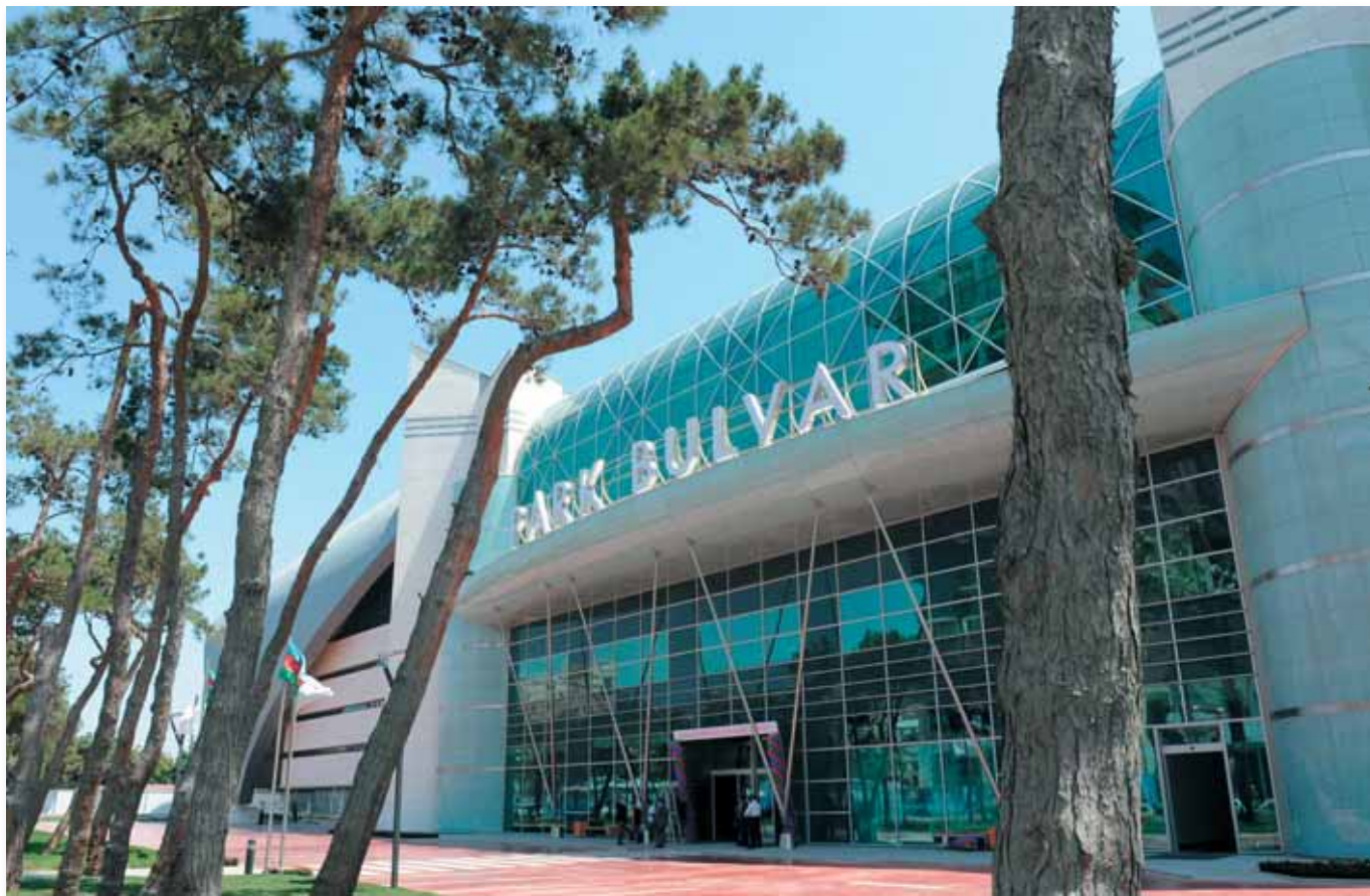
Проект: ТЦ «Park Bulvar» Город/Страна: Баку, Азербайджан Оборудование/решение: крышные вентиляторы DVN, DVS, DVV, DVG
