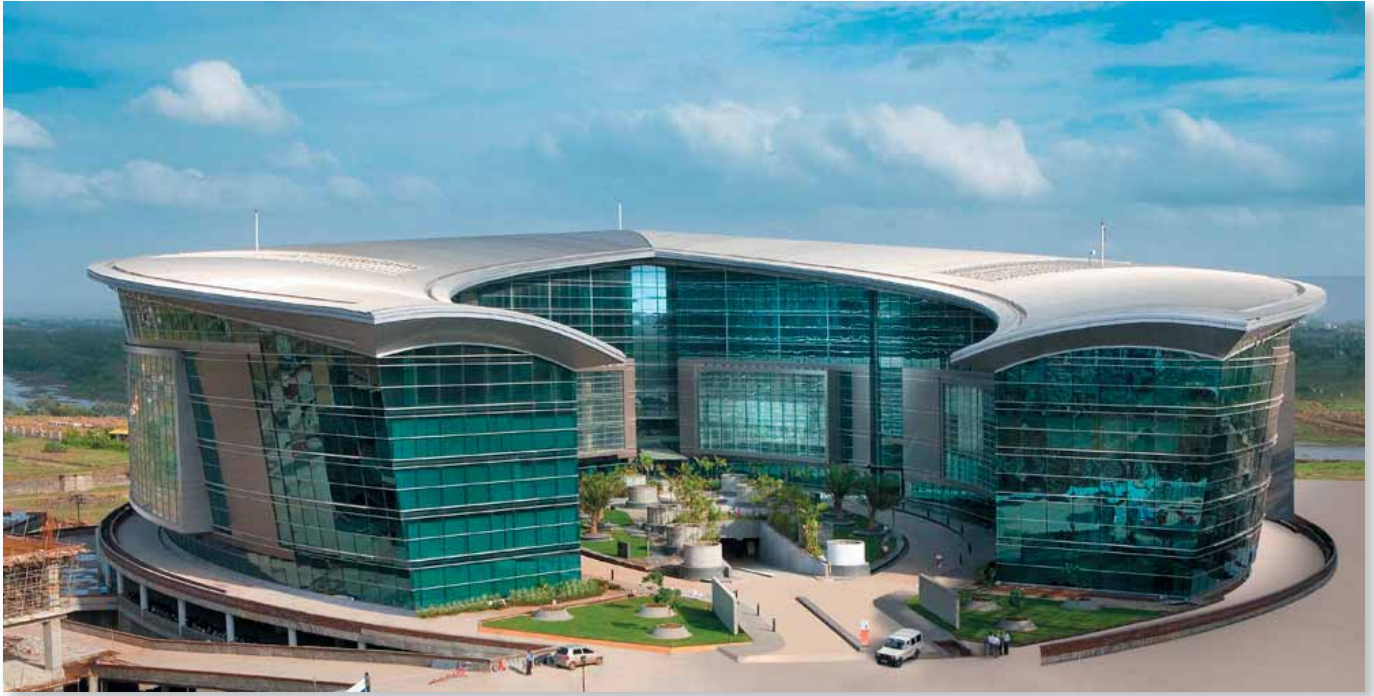
Проект: EON Kharadi Тип здания: SEZ IT Park Город / страна: Пуна, Индия Оборудование / решение: MUB, вентиляторы для круглых воздуховодов (K, KD), осевые вентиляторы, вентиляторы Jet, решетки
