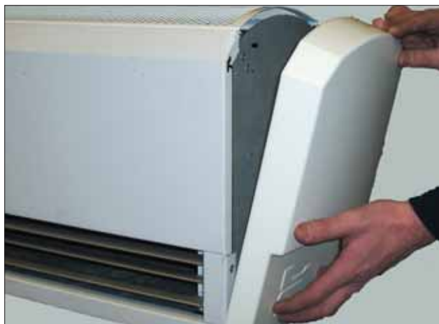
Рис. 55. Установка боковых панелей завес серий С, Т, НР, РНV
