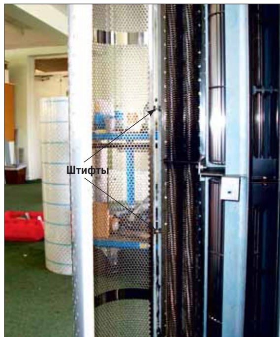
Рис. 48. Закрепление панелей на горизонтальные завесы серии DESIGNER
