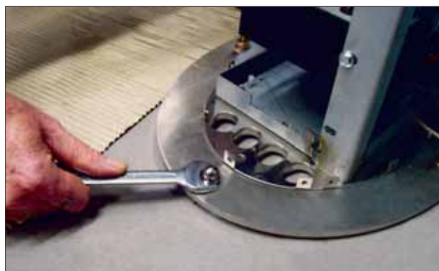
Рис. 47. Напольный монтаж
