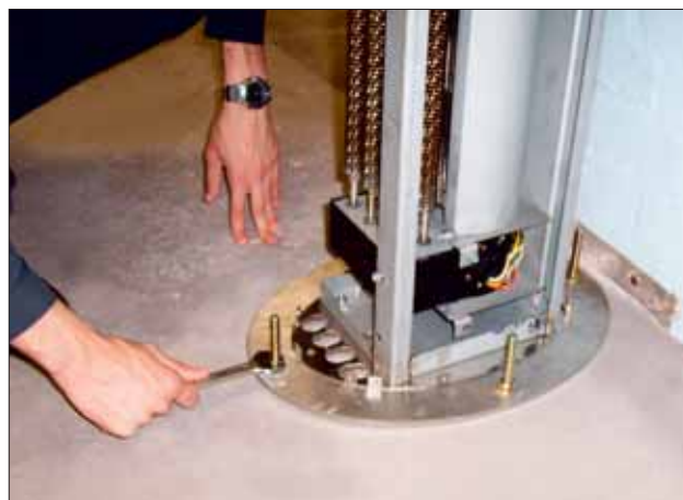
Рис. 45. Напольный монтаж (крепление)
