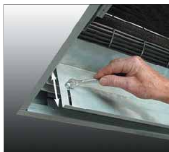
Рис. 26. Регулирование разделительной решетки
