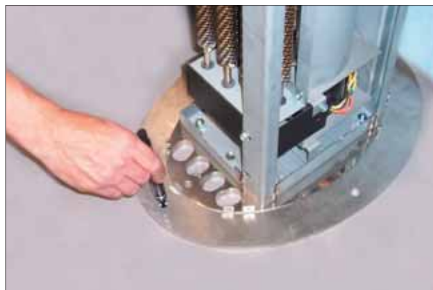
Рис. 44. Напольный монтаж (разметка)
